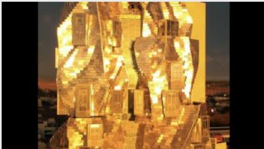
[CHANTIER] FONDATION LUMA - EIFFAGE MÉTAL
