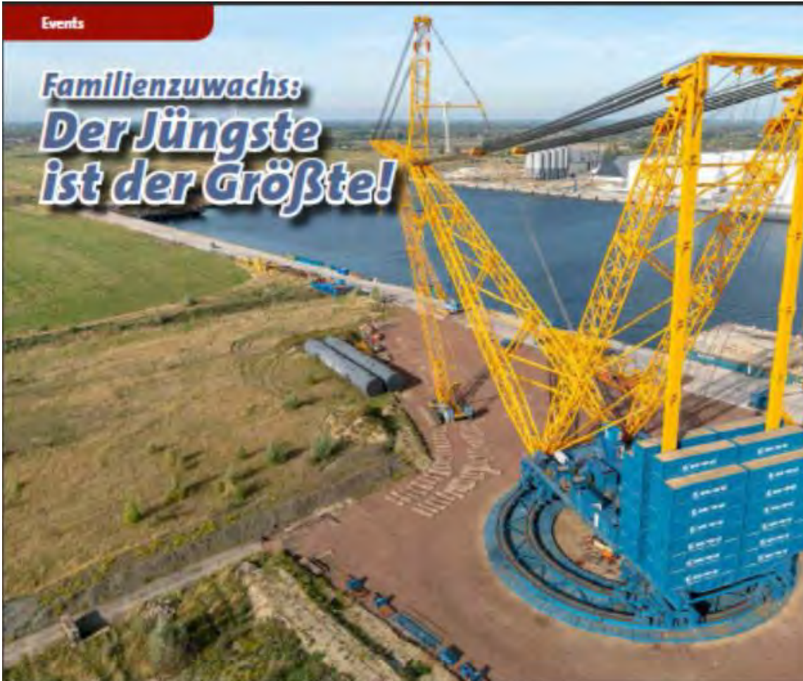
Die Vorbereitungen für die Montage des SGC-250 laufen auf Hochtouren: Hier wird der Wippausleger gerüstet.
