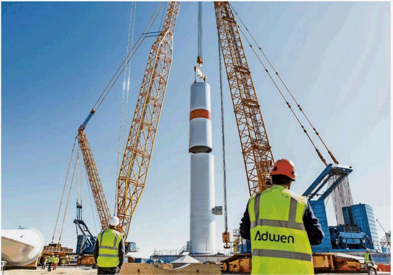
Bei idealem Wetter setzte der Riesenkran in dieser Woche **die dritte von fünf Sektionen** auf den Turm des Windradprototypen.
