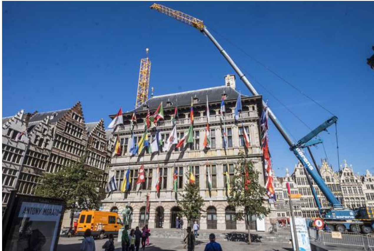
Een enorme kraan hijst onderdelen van een kraan over het gebouw. - Foto Klaas De Scheerder
