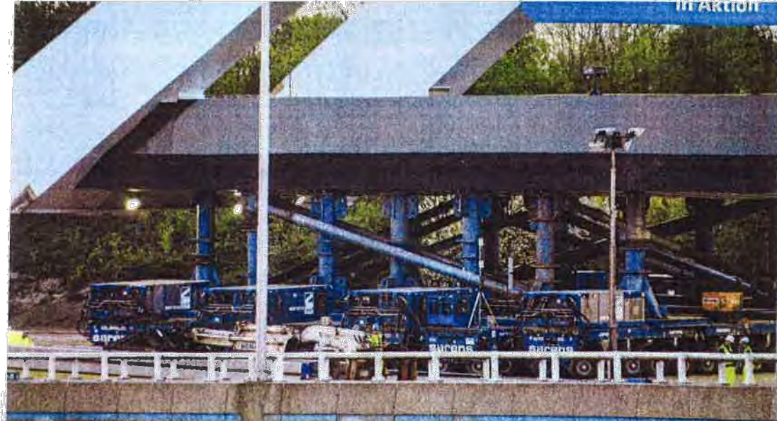
Insgesamt 244 Komag-Achslinien setzte Sarens für den Transport der Brücke ein. Bild: Hermann Schulte
