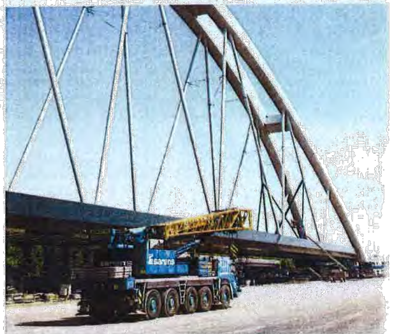
Die Transportvorbereitungen sind im vollen Gange.
