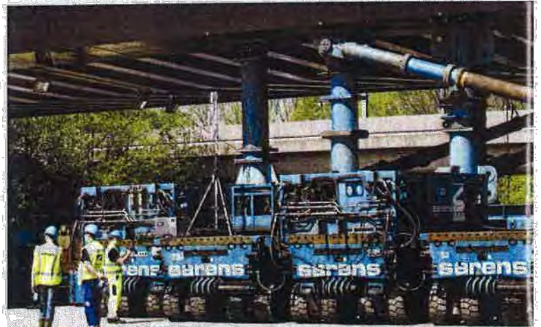
Die Tragekonstruktion und die Anschlussstellen der Brücke wurden verstärkt, um die potentiellen Kräfte aufnehmen zu können.
