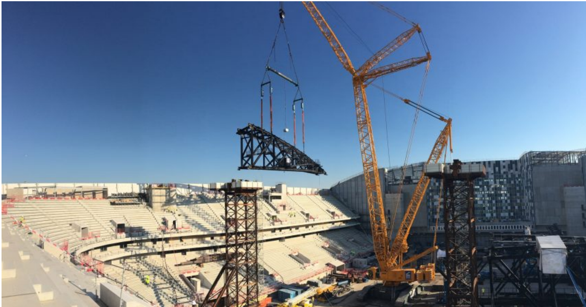
La pose de la grande poutre métallique MS1 sur le chantier de l'Arena 92 le 17 août 2016 - DR
