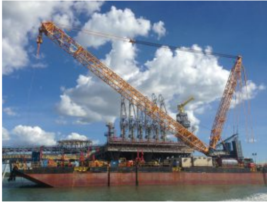
Ichthys LNG heavy lift works (Image courtesy of Sarens)
