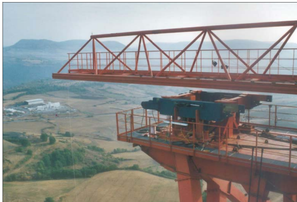
Client: Eiffage Location: Millau - Frankrijk
