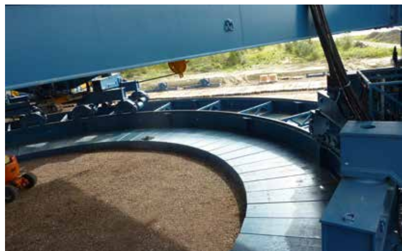
64 Stahlmatten bilden die Basis des Krans, auf ihnen wird das Schienensystem aufgebaut.
